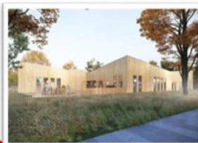
Gminne Przedszkole w Regułach (w budowie)
